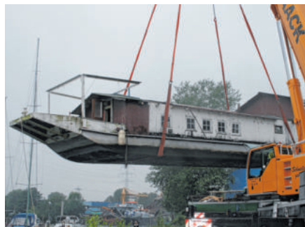
Mit einem Kran wurde der Rumpf für den Ausbau aus dem Wasser geholt
